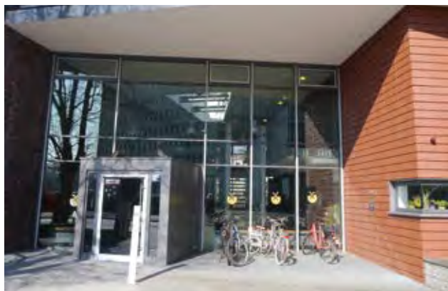
Der Eingangsbereich zur Wohnstätte Büntepark
